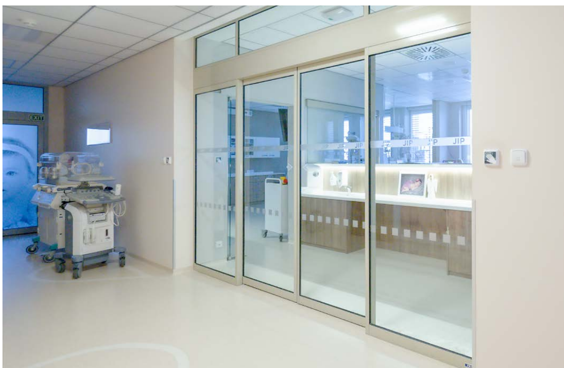
> Nemocnice Hořovice, prosklené dveře do neo- natologického oddělení
